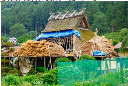
美山町北村の現場、南面の葺き替え作業中
