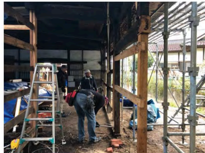
構造の補強工事
