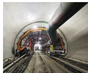
▲トンネル本体工事
