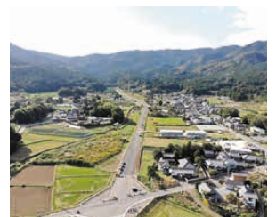
▲トンネル上空
