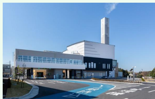
【広域ごみ処理施設 クリーンセンターみらい】
