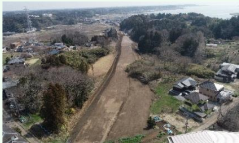
【貝地・高浜線 工事の様子】
