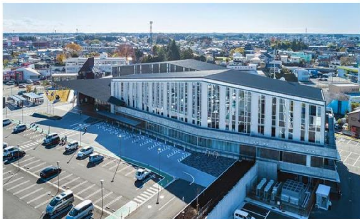
石岡市本庁舎駐車場に設置されている LED 照明
