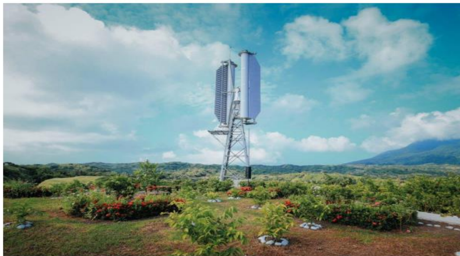
垂直軸型マグナス式風力発電機
