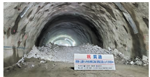
▲貫通した（仮称）上曾トンネル
