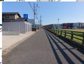
市道A3374号線 車道幅員6.0m
