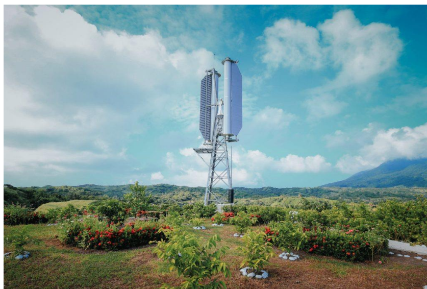
垂直軸型マグナス式風力発電機
