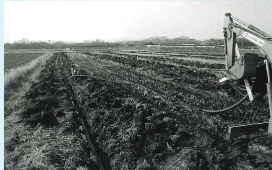
暗渠排水工事
