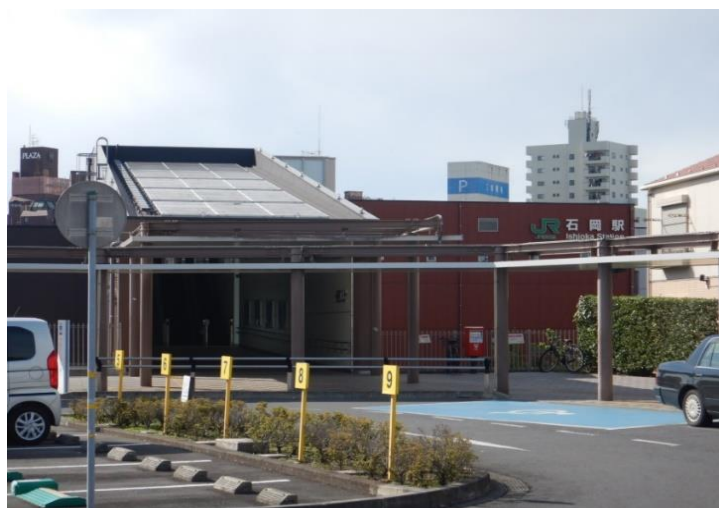
再生可能エネルギーを活用した生活空間の向上 (石岡駅の屋根置きソーラー発電と蓄電池の設置)
