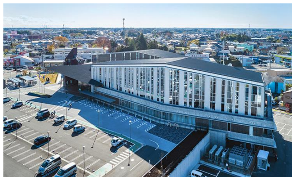
本庁舎駐車場に設置されている LED 照明
