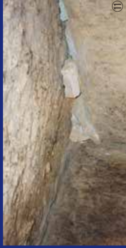
壁石の転倒の原因となっていた壁石と天井石の隙間には、埋め石を行いました⑪。
