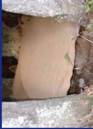
▲震災直後（平成23年3月17日撮影）
