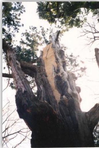
▲開口部閉鎖作業
