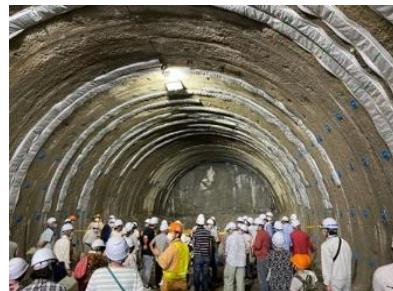
【上曾トンネル本体工事の様子】
