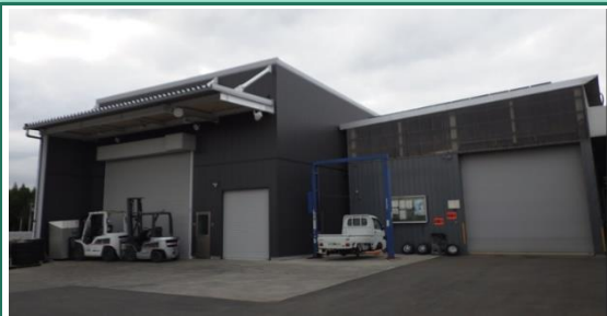
作業用倉庫を2023年に新築しました。
