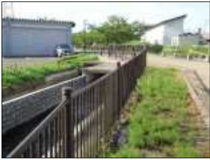
遊歩道沿いに安全防護柵の設置 (秋田県横手市)
