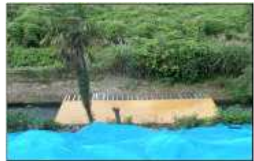
水路への仮蓋の設置
