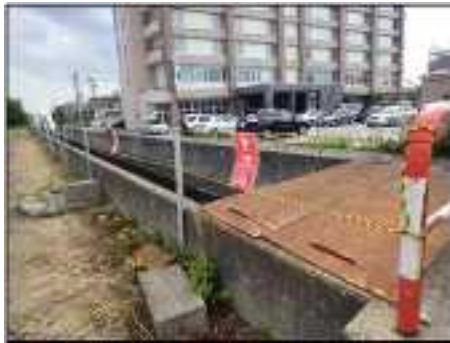
応急ロープの設置
