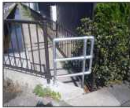
侵入防止柵を設置 (新潟県新潟市)
