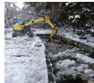
重機による氷塊除去
