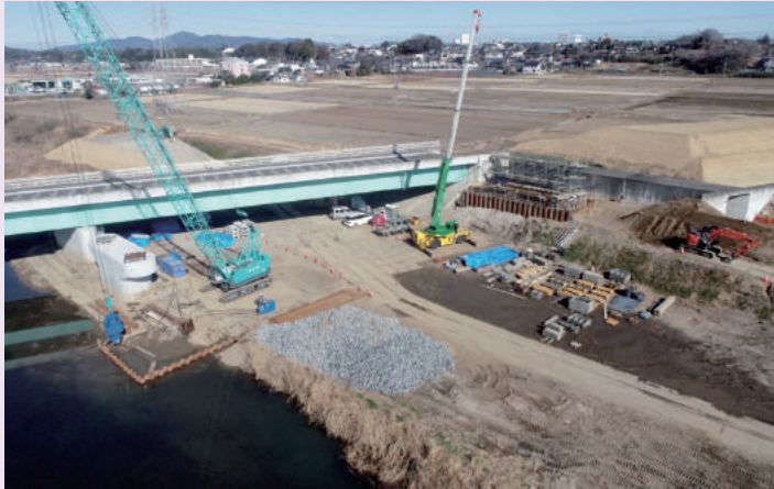
▲恋瀬橋下部工事
