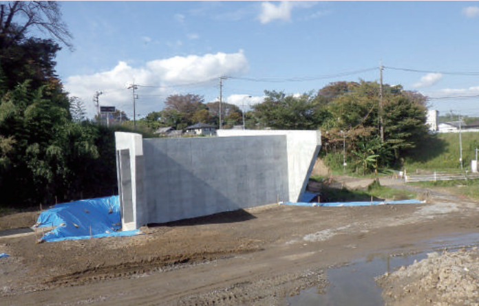
▲市川地区改良工事
