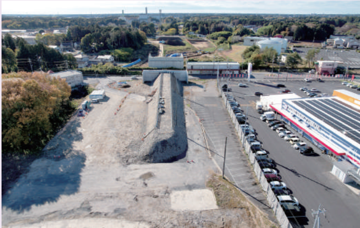
▲玉里高架橋上部工事
