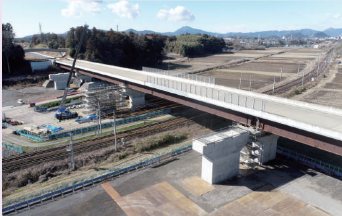
▲東田中高架橋下部工事
