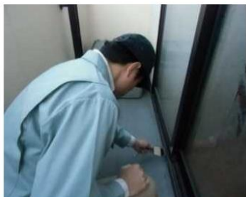
「外部（バルコニー）」調査の様子
