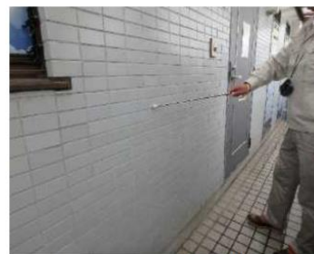
「外部（外壁）」調査の様子
