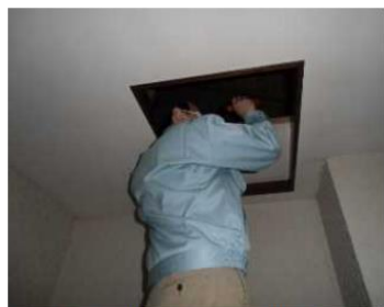
「小屋組・梁」調査の様子
