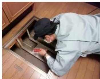
「土台・床組、基礎」調査の様子
