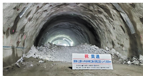
▲貫通した（仮称）上曽トンネル
