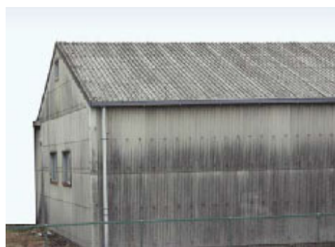
石綿含有スレート波板（屋根・外壁）
