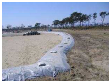
遮水シートを敷設した仮置場の事例 出典：仙台市ホームページ
