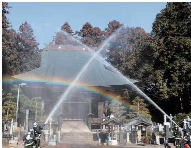
▲石岡市指定文化財・盛賢寺阿弥陀堂での放水訓練。
