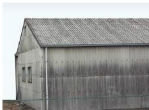
石綿含有スレート波板（屋根・外壁）
