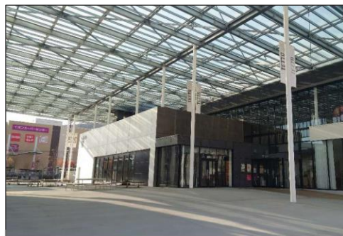
釜石市民ホール(半屋外広場)
