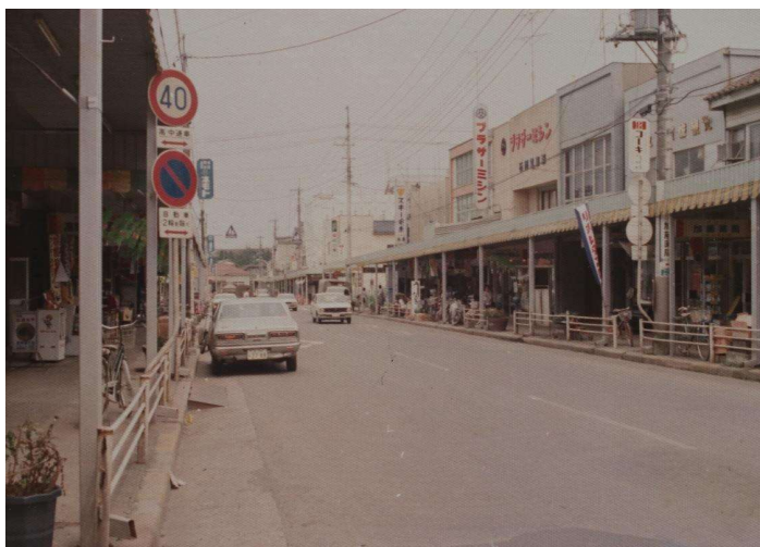
石岡停車場線 (八間道路) 左. 石岡駅方向
