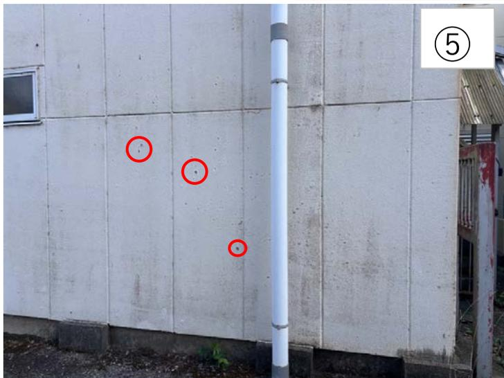
外壁ALC部 建物東側 補修材充填箇所図
