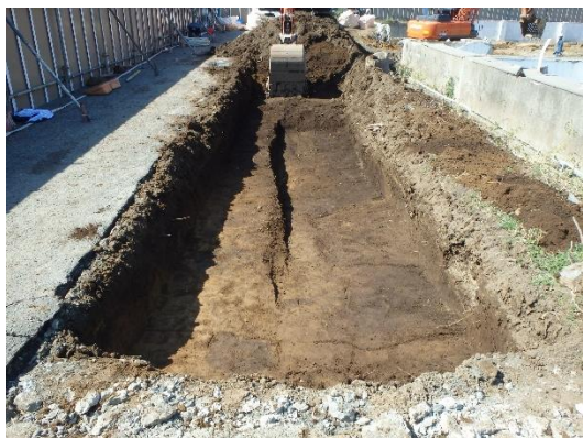
重機掘削の様子
