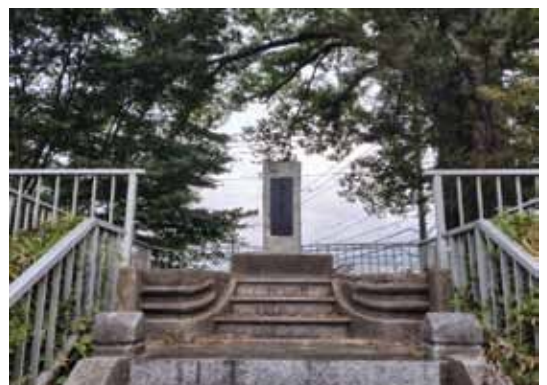
▲奉安殿の土台
