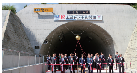
▲ 9月27日に開通した上曽トンネル
