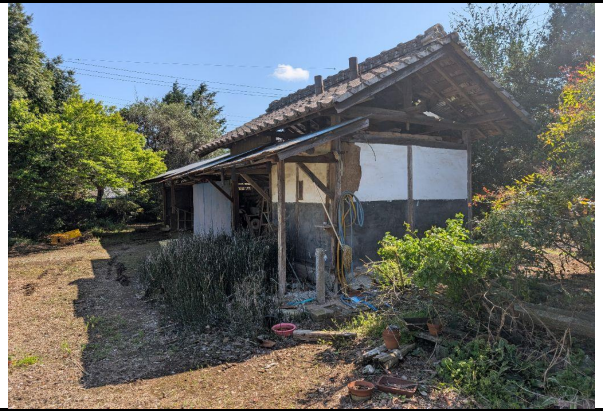
敷地内倉庫②
