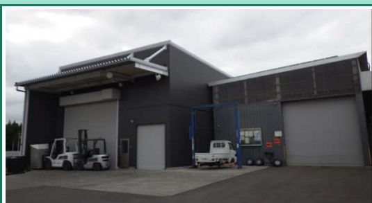
作業用倉庫を2023年に新築しました。
