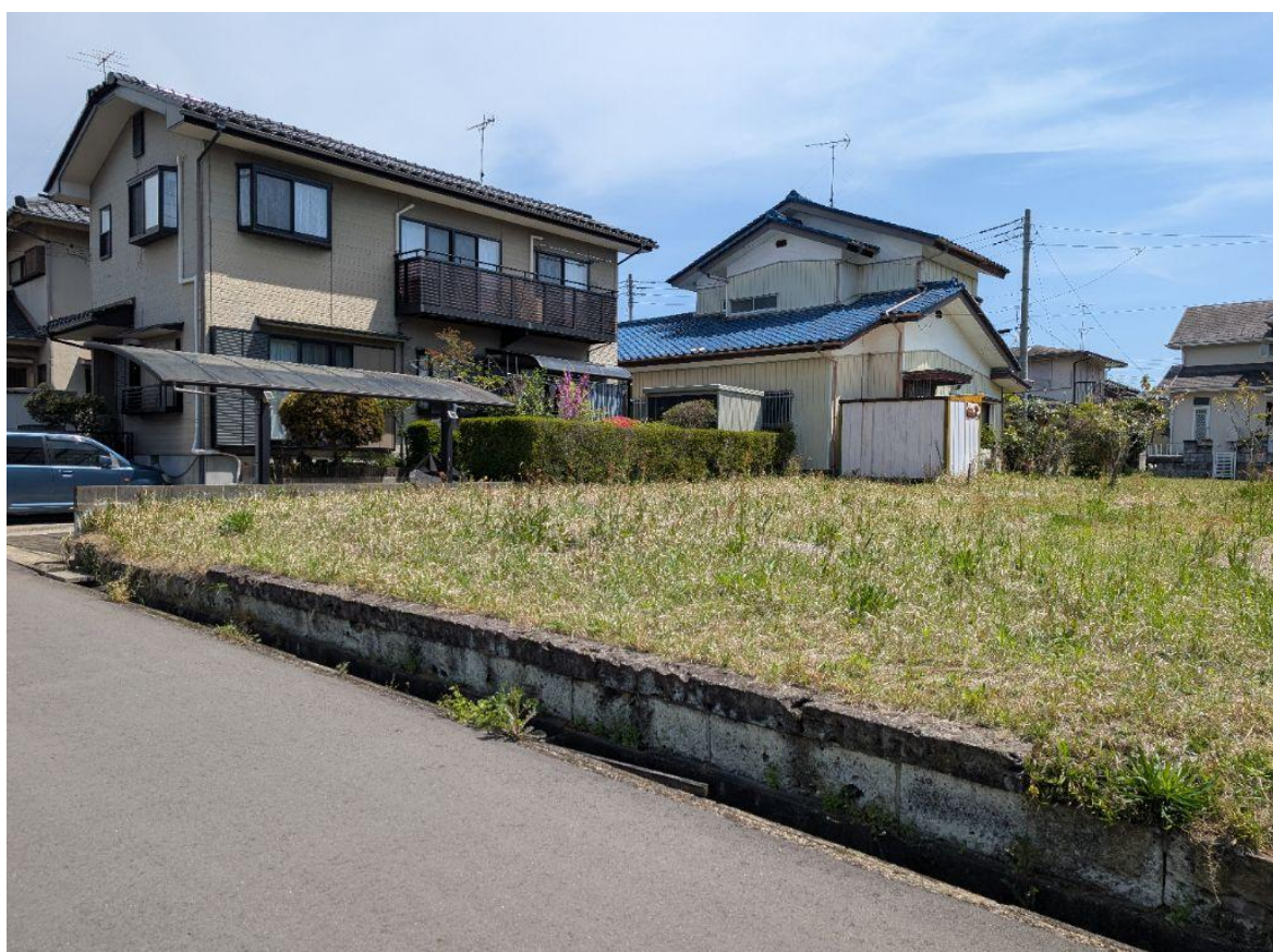
土地の全景及び前面道路
