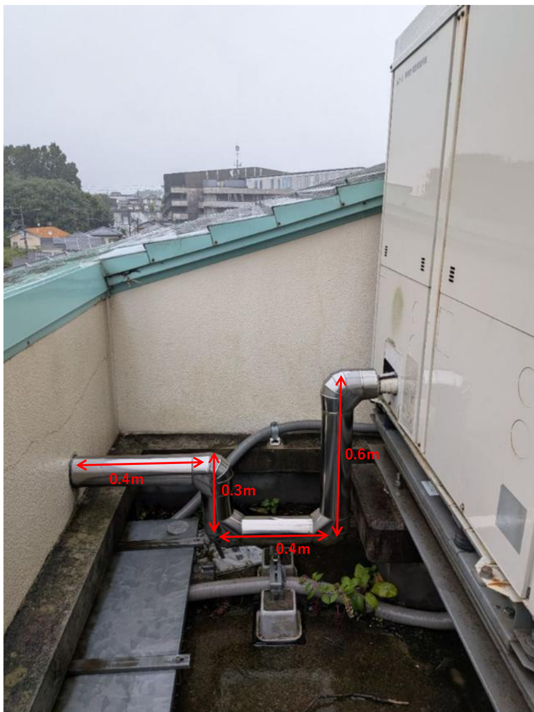
令和8年度 石岡市消防本部空調設備更新工事 既存配管SUSラッキング 計1.7m
