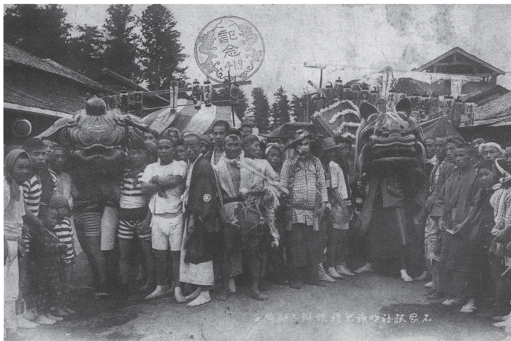
▲明治41年の土橋町と仲之内の幌獅子（土橋獅子舞保存会 1989『常陸総社宮例大祭と獅子』より）
