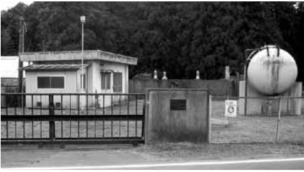
▲統合した簡易水道施設（大塚機場）
