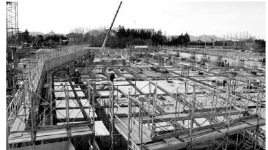
▲建設が進む市役所の新庁舎（平成30年1月撮影）
