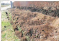
【左から写真説明】人家裏の崖が掘り起こされ、がけ崩れ（中戸地区）道路の境界を掘り起こされ車が通行できなくなっている（大增地区）掘り起こされた土や石が側溝に詰まり、雨水が流れなくなっている（上管地区）
