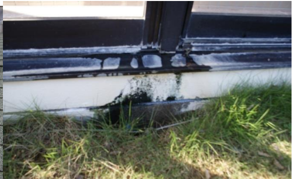
内湯の水漏れ
