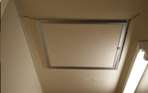
天井のひび割れ
