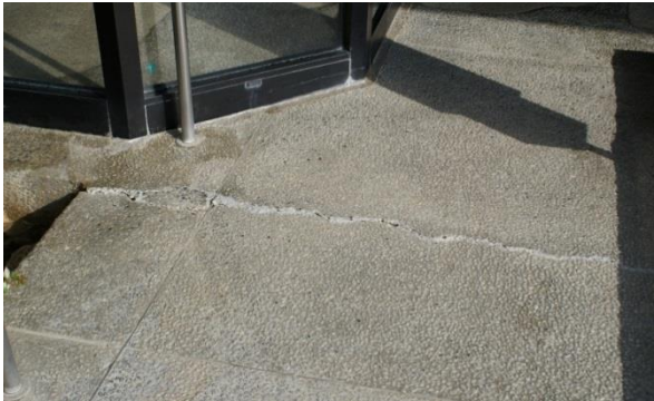
露天風呂の床のひび割れ
