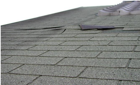
屋根材の損傷
