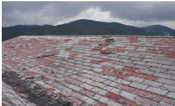
屋根材の損傷
