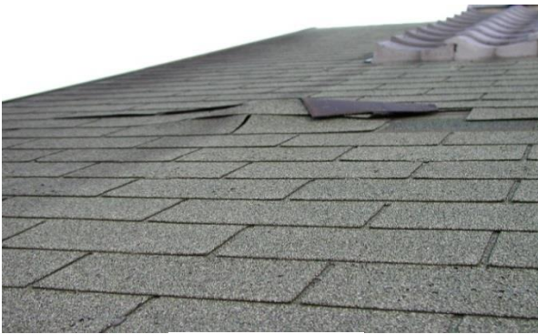
屋根材の損傷
