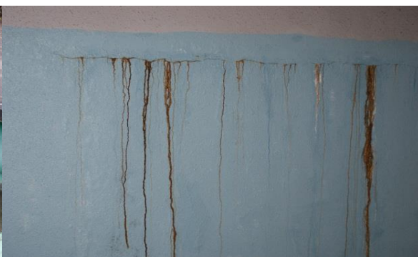
外壁からの漏水
