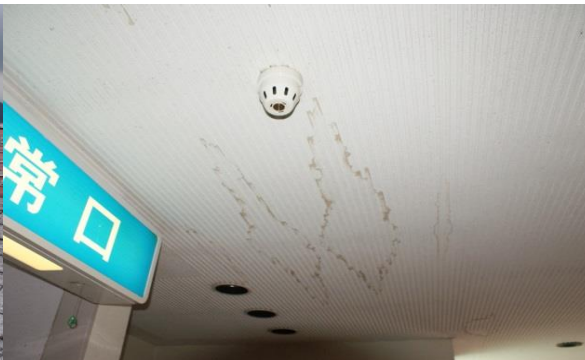
天井からの雨漏り
