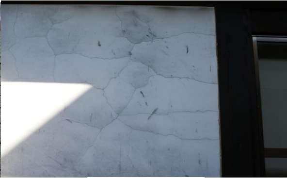
外壁のひび割れ
