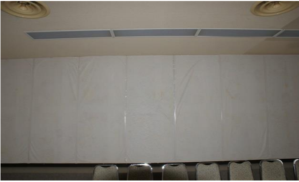
天井からの雨漏り
