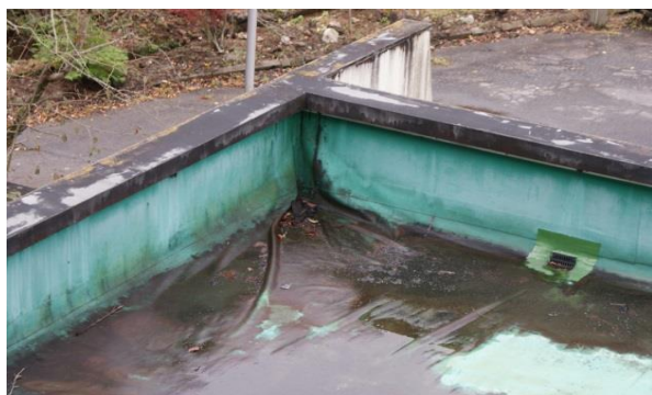
屋根材の損傷
