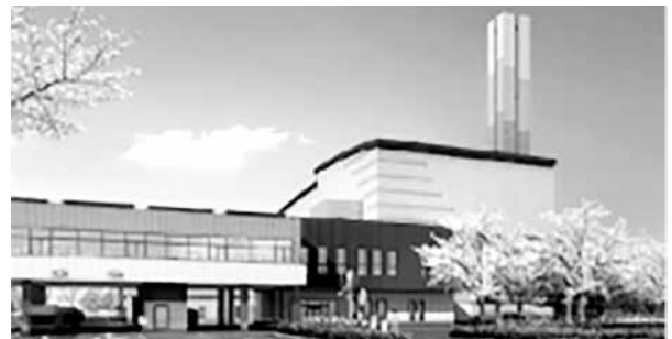
▲新広域ごみ処理施設「みらい」(完成イメージ)
