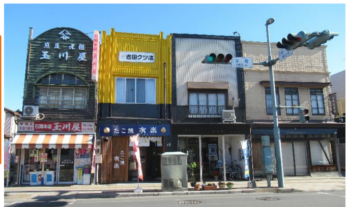
○修景により効果が見込まれる建築物群
