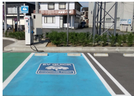
EVステーション
